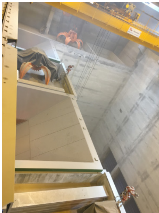
Ryc. 1. Widok otworów zasypowych między bunkrem i halą kotłów Fig. 1. View of charging holes between the bunker and the boiler hall
